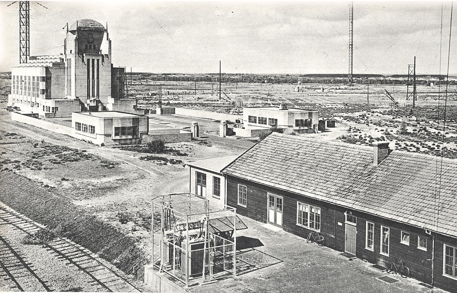
Als een Oostersch bouwwerk ligt het groote zendgebouw, waarin zich de 400 K.W.-machinezender benevens drie lampzenders voor het Europeesche verkeer bevinden, in de wijsche heidevlakte.
